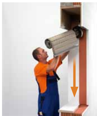
Alten Rollläden aus dem Kasten entfernen.
