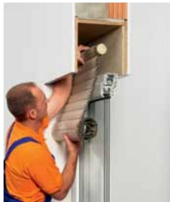
Alten Rollläden aus dem Kasten entfernen.
